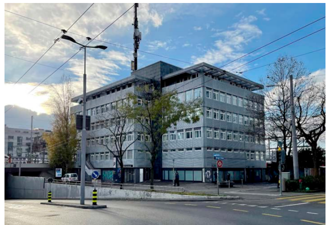
Abbildung 2: Foto Bestandsgebäude (SBB Immobilien AG)
